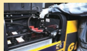
Batterie Hauptschalter (abschließbar)
