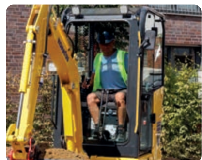
La vaste surface vitrée offre une excellente visibilité du chantier
