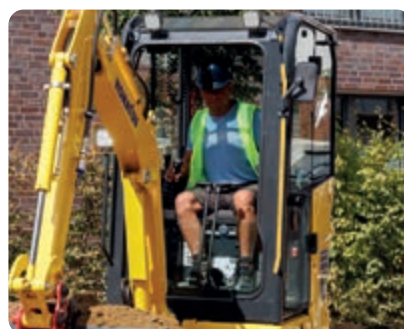
Stora glasfitor ger en utmärkt sikt runt om på arbetsplatsen
