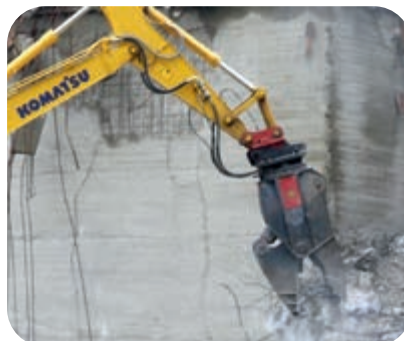
Twee optionele hydraulische leidingen waarop diverse hulpstukken gemonteerd kunnen worden
