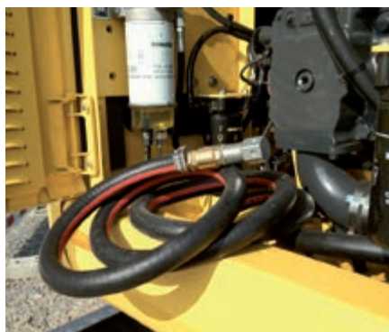
Pompa travaso gasolio
